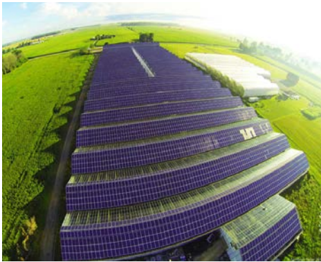
Figure 1 : Vine Fresh Produce Project est la plus grande installation en toiture en Ontario dans le cadre du programme FIT (2,3 MW). Ce projet est le plus grand système avec des micro-onduleurs d'Enphase au monde.
