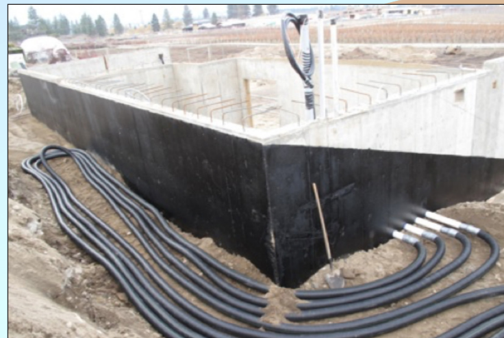
Figure 1. Configuration des tubes souterrains avec une couche abaissée déjà remblayée.
