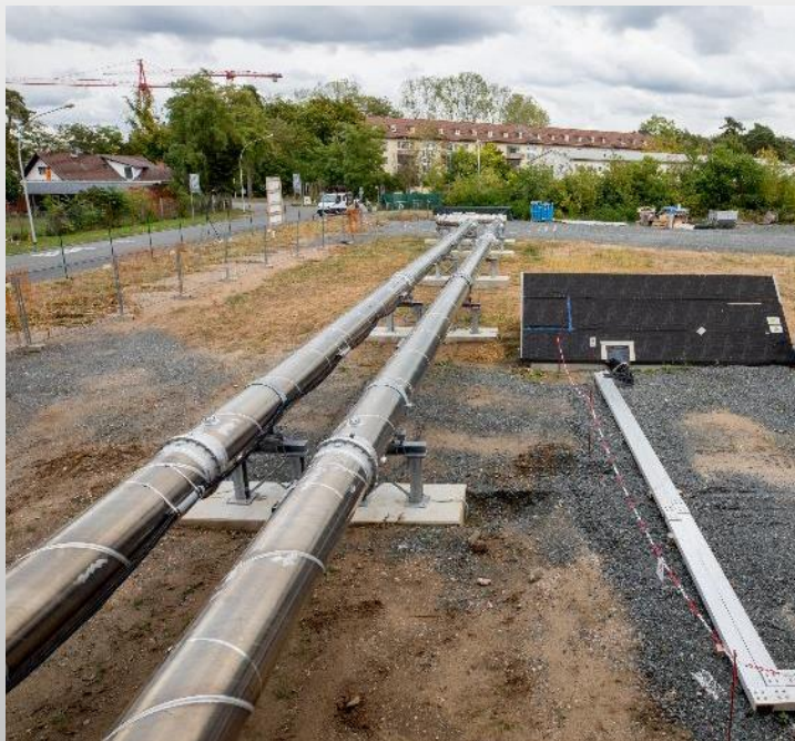
Figure 11 : Ligne pilote (phase de construction) pour les essais électriques; droit d'auteur Siemens 40
