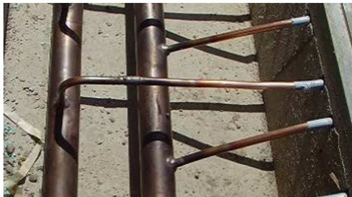
Figure 3 : Caniveau pour collecteurs de CO 2
