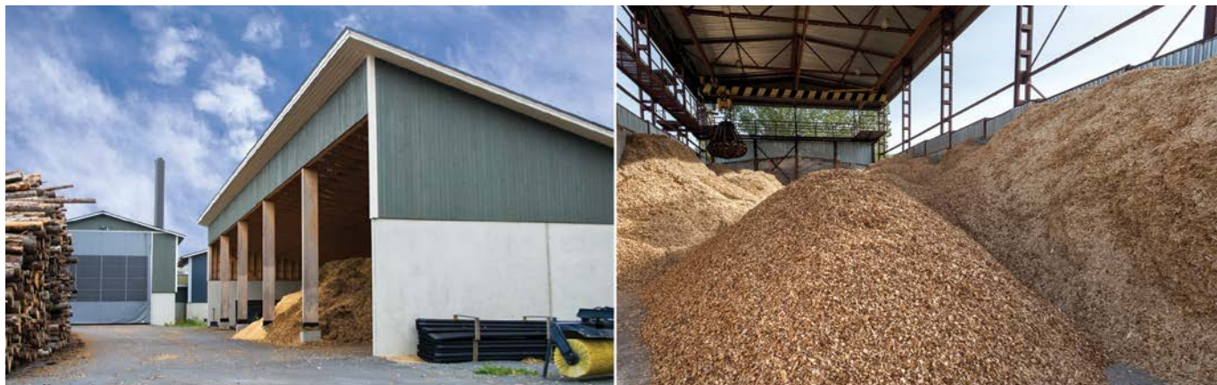
Figure 2. Abris couverts pour l'entreposage des copeaux de bois
